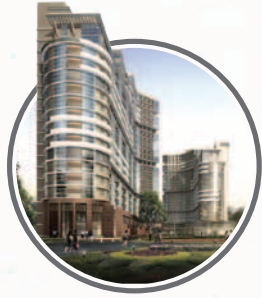
ЖК «Триумф» ул. Гаврилова, 27
